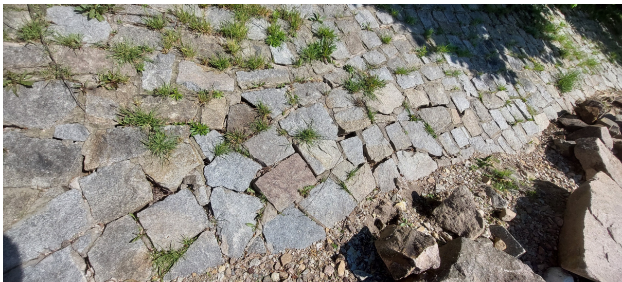
Obr. 9 – SO 02 – detail chybějícího vyspárování dlažby
