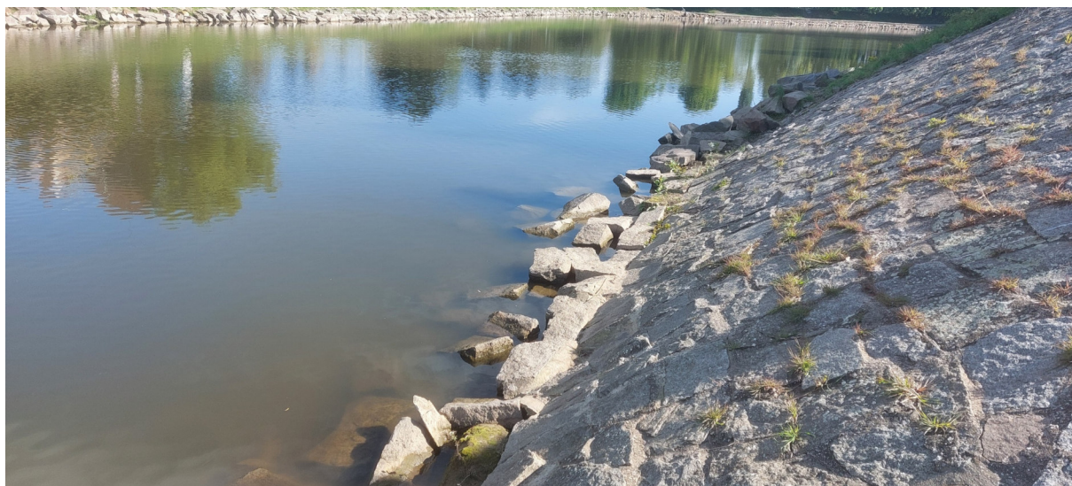
Obr. 7 – SO 02 – detail porušené patky
