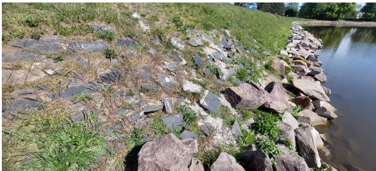
Obr. 4 – SO 01 – porucha dlažby o ploše 2,0 * 3,0 m
