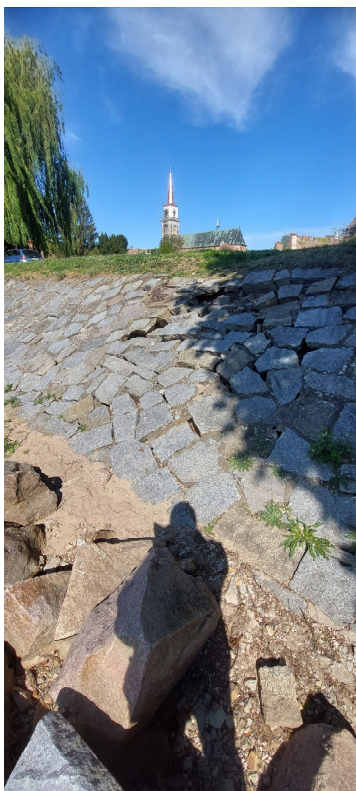
Obr. 8 – SO 02 – porušená dlažba v ploše cca 3,5 * 4,0 m
