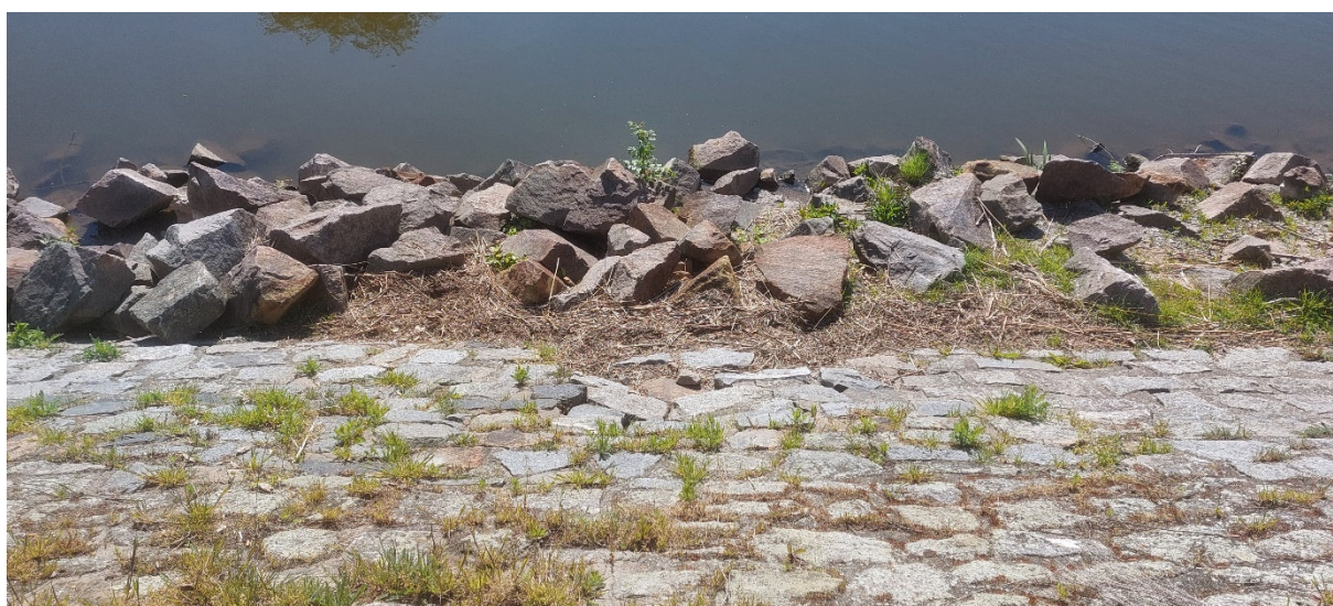
Obr. 5 – SO 01 – porucha dlažby o ploše 1,5 * 1,5 m
