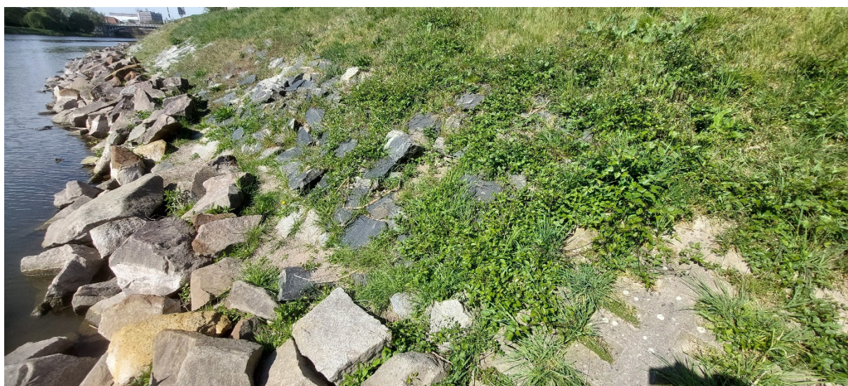
Obr. 3 – SO 01 – porucha dlažby o ploše 9,0 * 3,0 m
